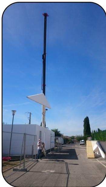
**Micro-crèche** : les travaux ont commencé et s'achèveront à la mi-novembre. L'ossature bois permet d'avancer très rapidement. Exemple du **5 octobre 2016** : 8h00 les camions arrivent sur place, 8h48 le déchargement attaque, 9h30 la pose des murs commence, 12h00 pose du pignon de toiture, 16h00 les fermettes sont posées .....
